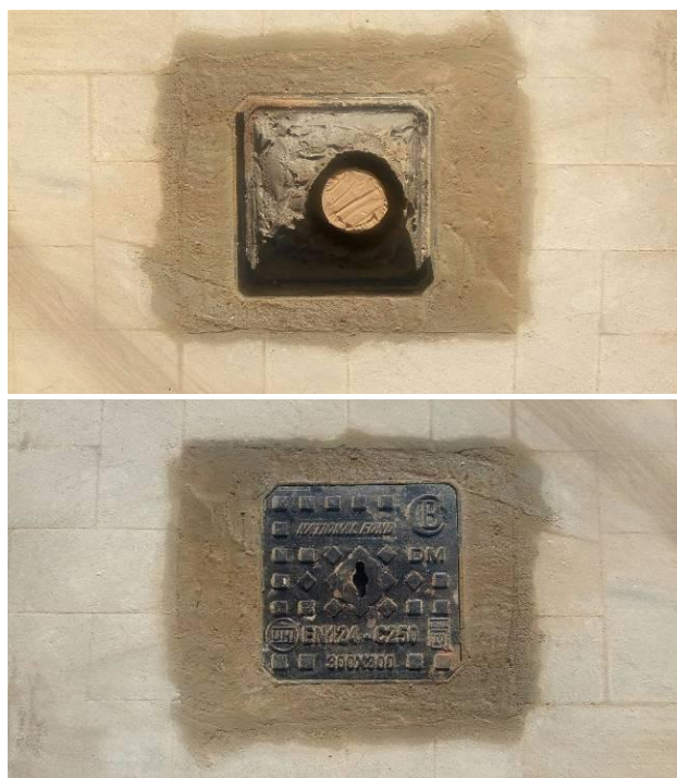
Foto 11: A sinistra, fase di installazione della tubazione in pvc per la prova down hole; in alto, pozzetto di protezione carrabile installato per la protezione della tubazione installata.
