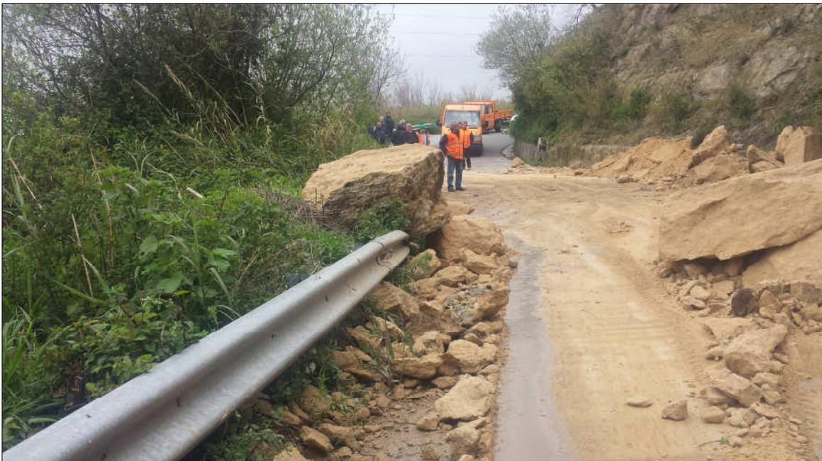
**In primo piano: impatto sul piano viabile e barriere di protezione laterale danneggiate dai blocchi (foto 2015)**
