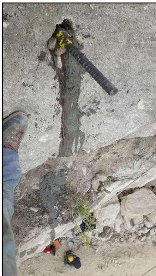
FOTO 04 : ESECUZIONE DELLE CEMENTAZIONI DEGLI ANCORAGGI
