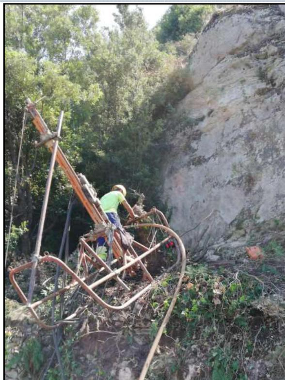
FOTO 03 : ESECUZIONE DELLE PERFORAZIONI PER GLI ANCORAGGI N. 6 E N. 2.
