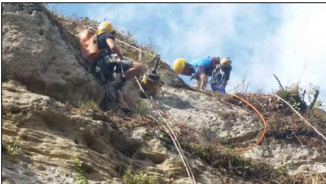
FOTO 05: ESECUZIONE DELLE TESATURE A SFILAMENTO
