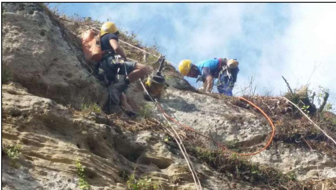
FOTO 05: ESECUZIONE DELLE TESATURE A SFILAMENTO
