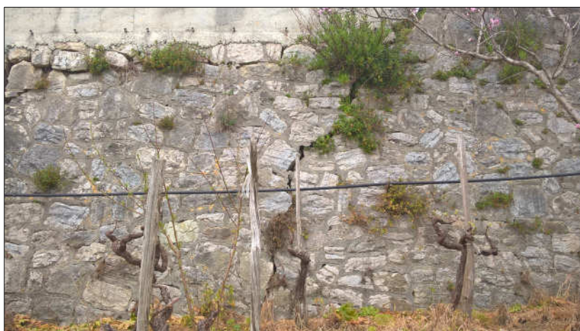
Tratto di muro lato valle lesionato in corrispondenza del Km. 1 + 700 SP. 87
