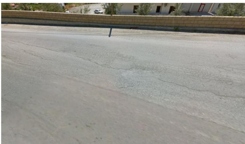
A causa delle limitate risorse dell'Ente, ed agli ingenti flussi veicolari - che interessano la S.P. 82 - il piano viabile ha subito, nel tempo, numerose deformazioni visco-elastiche con formazioni di ormaie ed avvallamenti. Inoltre, non è stato possibile provvedere alla collocazione delle necessarie
