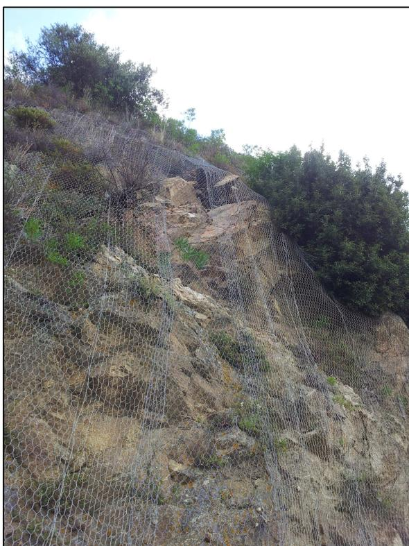
Al fine di poter riaprire al transito il tratto di strada interrotta, garantendo un sufficiente standard di sicurezza all'utenza, occorre intervenire per intercettare e pilotare tutte le parti corticali del costone roccioso ritenute allentate ed instabili e quindi prossime al distacco.
