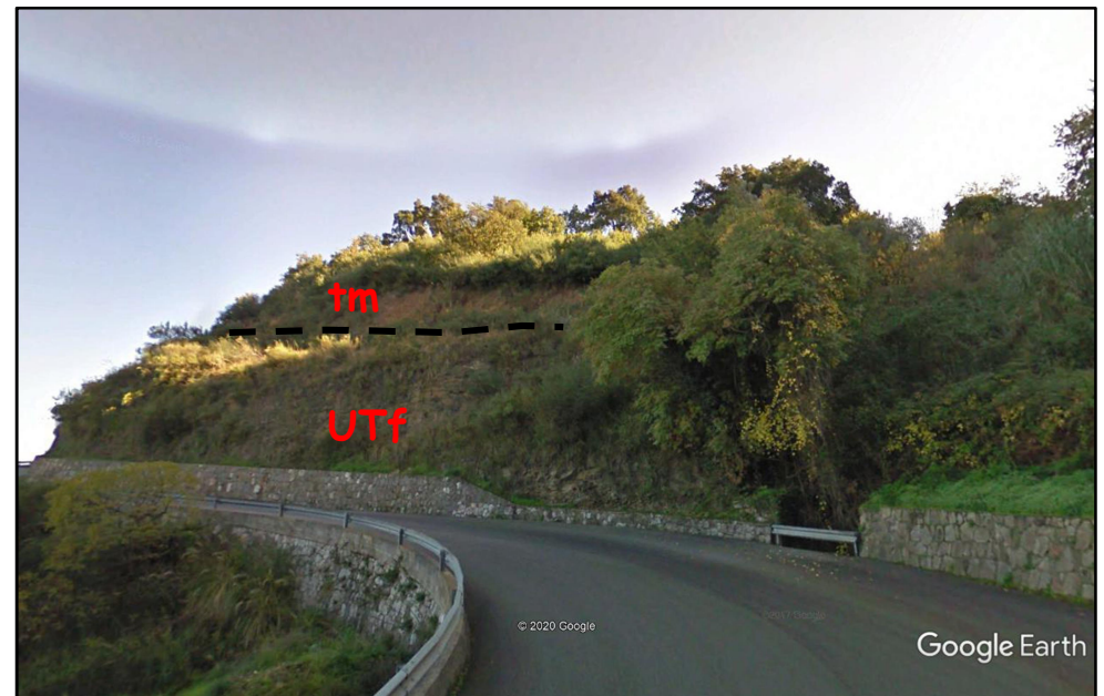
Assetto lito-stratigrafico lungo la scarpata a monte della S.P. n. 160
