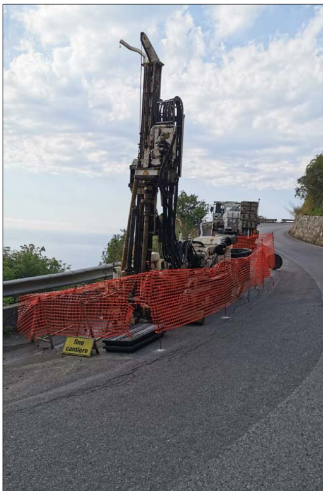
Foto 1: Postazione sondaggio S1
