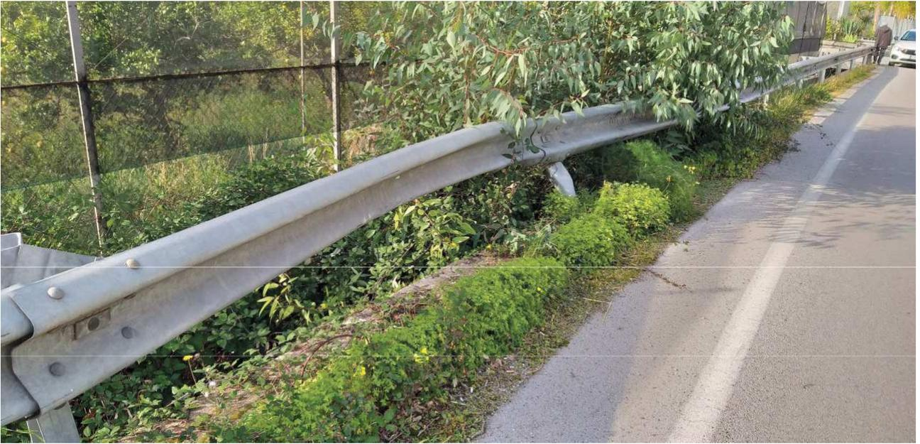
Particolare barriera deformata da riallineare al km.1+000 lato dx
