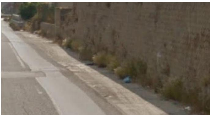
mediante la sistemazione del piano di calpestio, con una stesa di conglomerato cementizio (previa demolizione della parte disconnessa) della parte superficiale del camminamento ed alla sistemazione del tratto mancante dal km 5+070 al km 5+885 lato monte.
