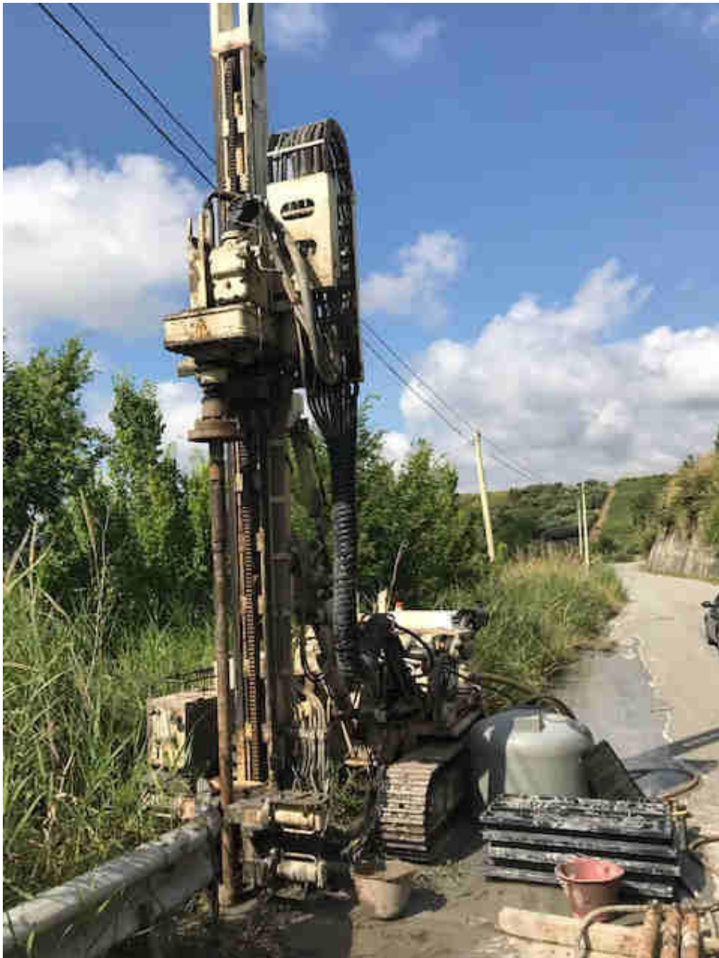
Postazione di lavoro sondaggio S1
