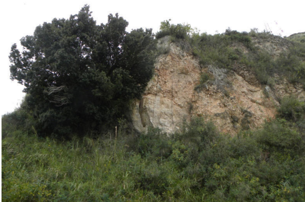
(foto sopra- particolare intervento Km. 8 + 000 circa c/da Scalone-Torrione: brecce calcaree fratturate)
