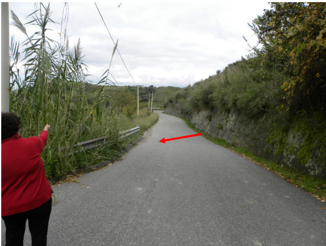
Particolare del sito d'intervento in località Rapano Inferiore – sp. 54/bis Km. 5+250
