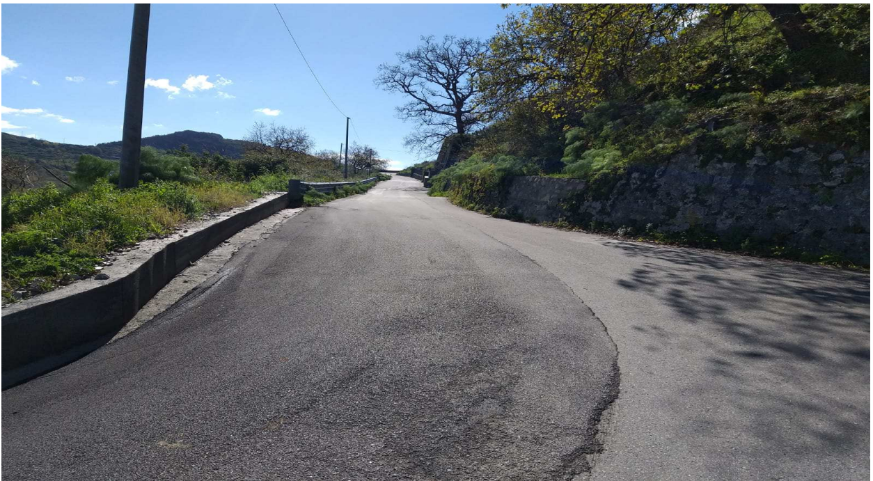
Vista delle condizioni in cui versa la S.P.
