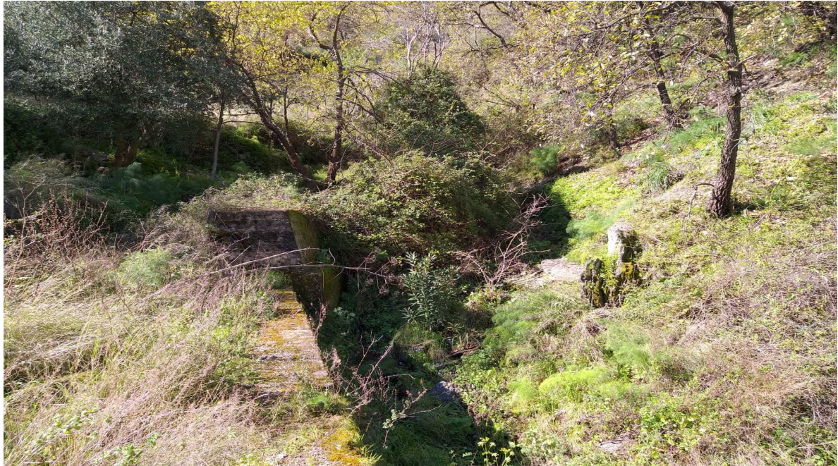
Vista delle condizioni in cui versano le opere di raccolta delle acque meteoriche
