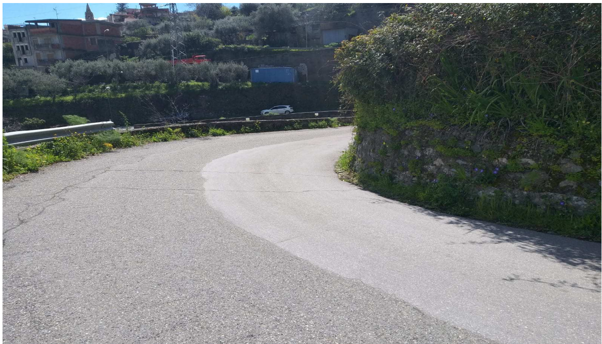
Vista delle condizioni in cui versano i parapetti esistenti e le barriere di sicurezza
