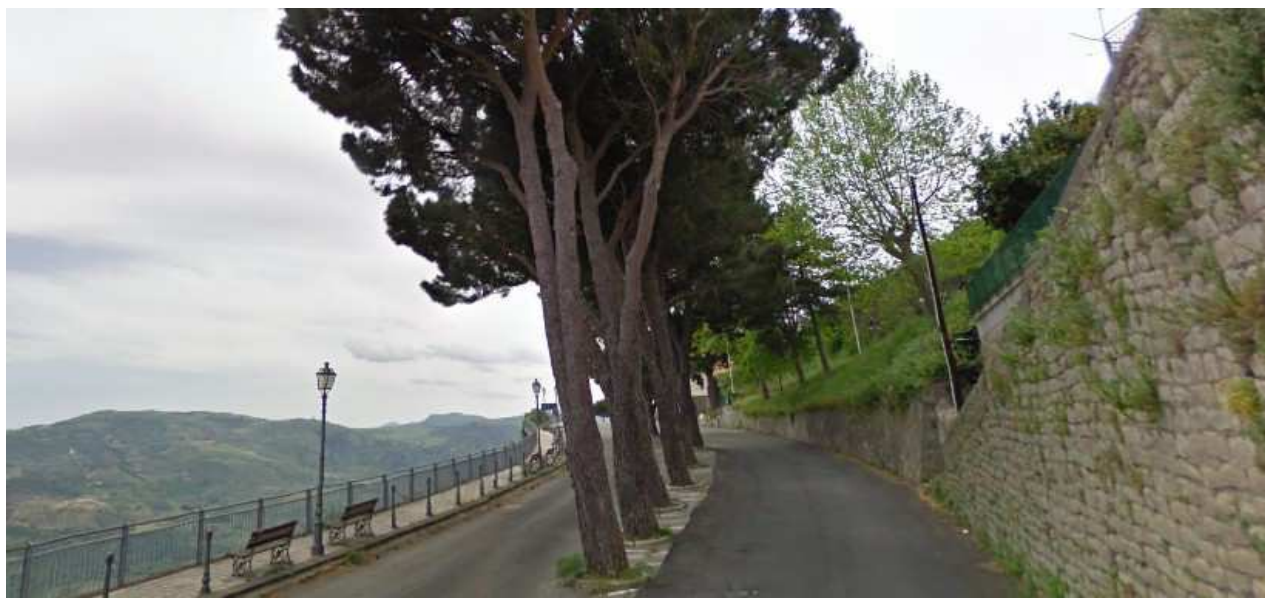
SP.126 di Librizzi – Km 4+050 circa pavimentazione ammalorata dalle radici in risalita
