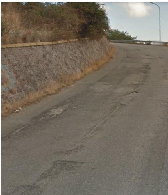
veicolari - che interessano la S.P. 44 Campo Italia – il piano viabile ha subito, nel tempo, numerose deformazioni visco-elastiche con formazioni di ormaie ed avvallamenti, che non sono state oggetto di un necessario piano di manutenzione.
