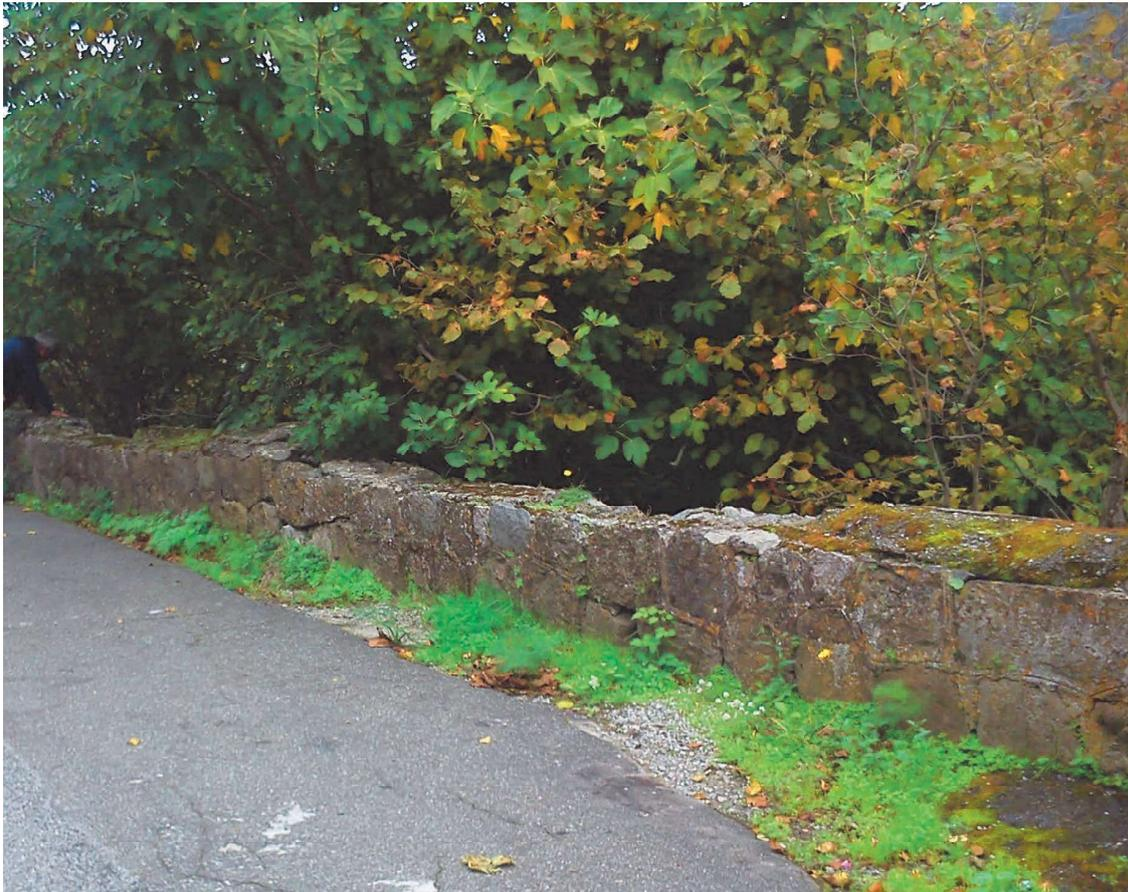
Diramazione per la frazione di Badiavecchia - parapetti ammalorati
