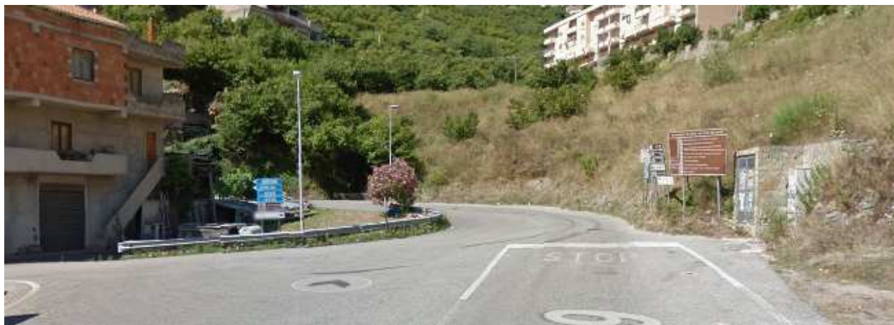
Ingresso del centro abitato di Ucria - area interessata alla realizzazione dell’ aiuola centrale ed alla cunetta con muretto di pulizia
