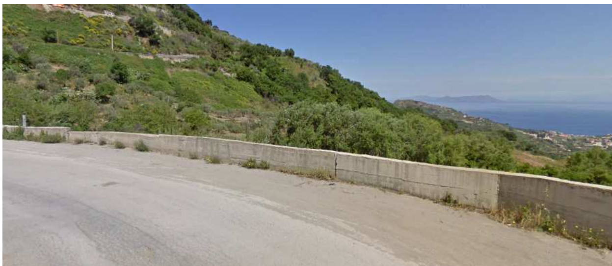
Km 0+760 della SP. 128 di Macera- restauro del parapetto
