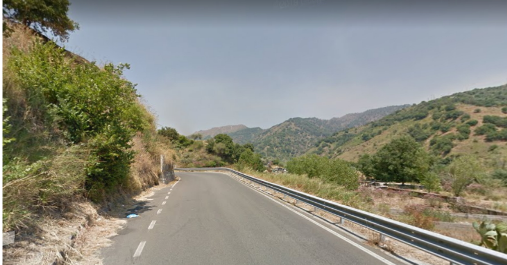
SP.7 di Graniti Km 1+350 circa – consolidamento corticale
