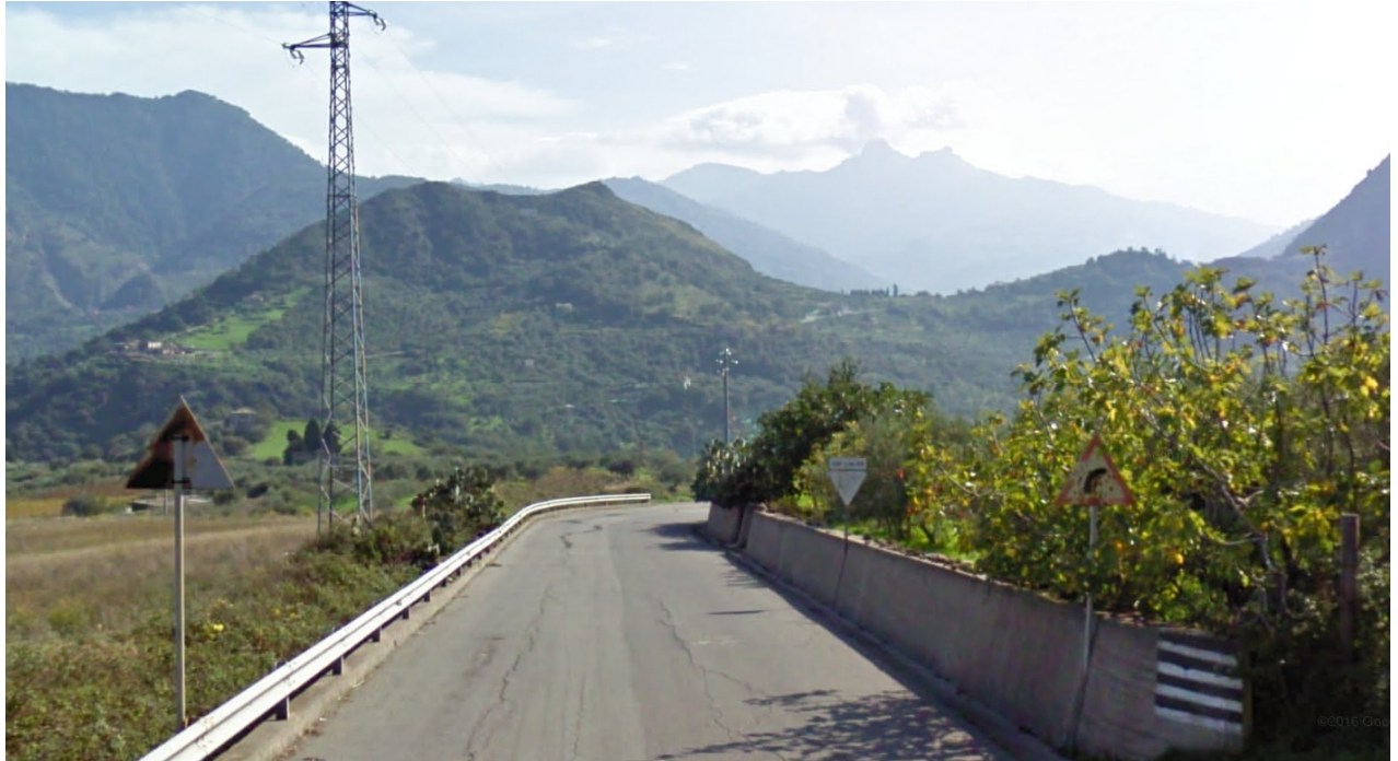
SP 112 bis di Campogrande Km 0+230
