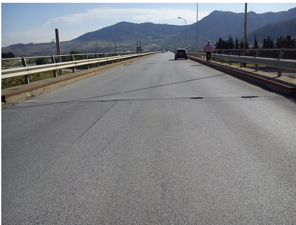
SP.100 di S.Enargi Km 1+700
