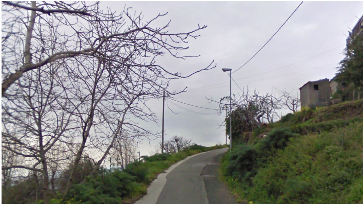
SP 112 diramazione per Contrada Piattaforma Km 0+200
