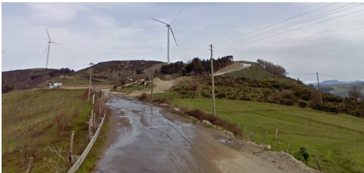
Zona intervento 11- consolidamento del piano stradale
