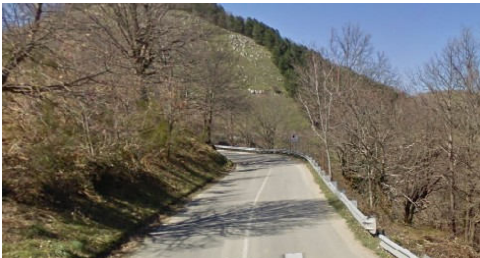
zona INTERVENTO 1– spalletta segna margine (compreso smonto e successiva ricollocazione della barriera metallica)
