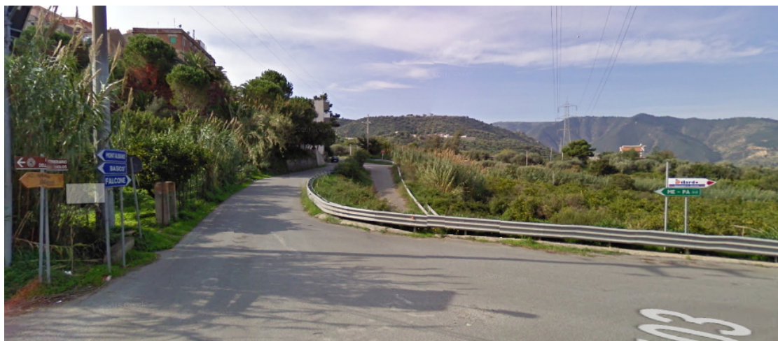
(foto 4 - SP.103 INTERVENTO 2 Km 1+015)
