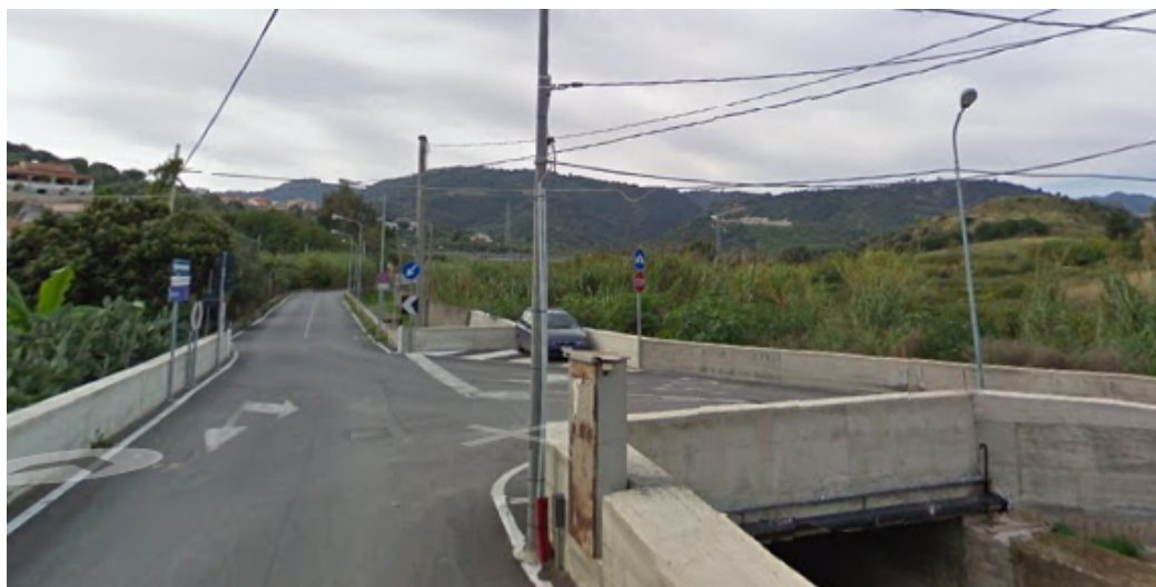
(foto 3 - SP.103 INTERVENTO 1 al Km 0+415)
