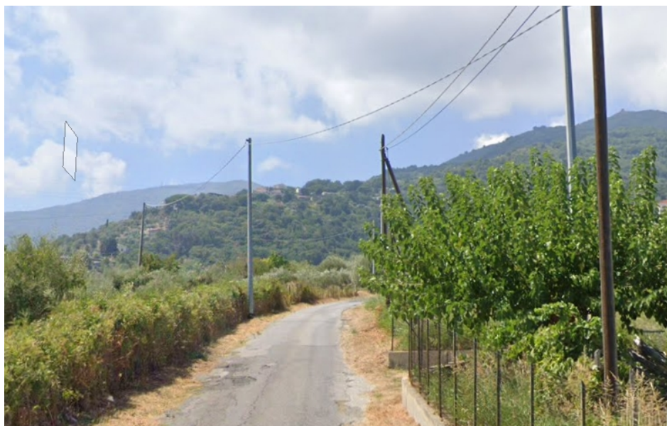
SP. 125 della Sisa di Patti INTERVENTO 1 Km 0+460
