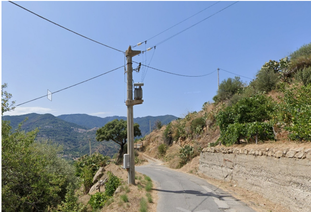
SP. 120 di Scarpiglia INTERVENTO 1 Km 4+550
