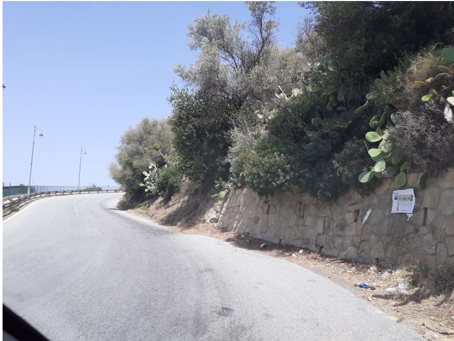
SP.107 Km 0+350 INTERVENTO 2
