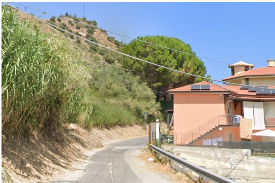
SP. 124 di SAN Paolo Gallo Km 0+000 INTERVENTO 1
