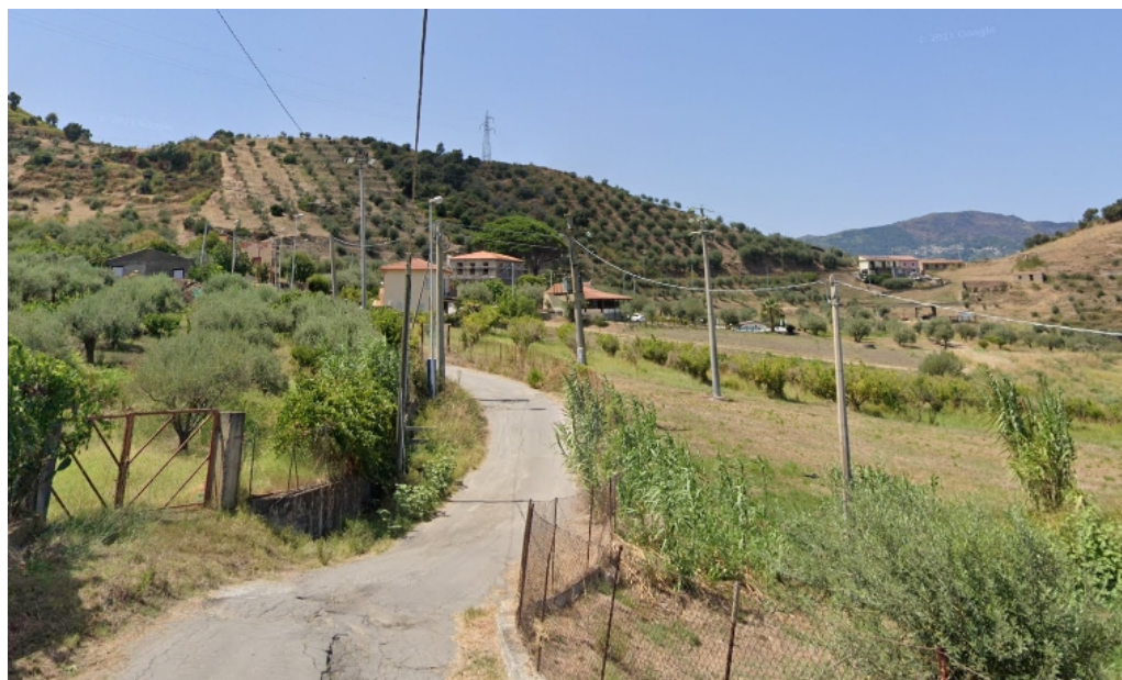
SP. 129/c SP.119 di Moreri – Grisiola INTERVENTO 3 Km 0+650
