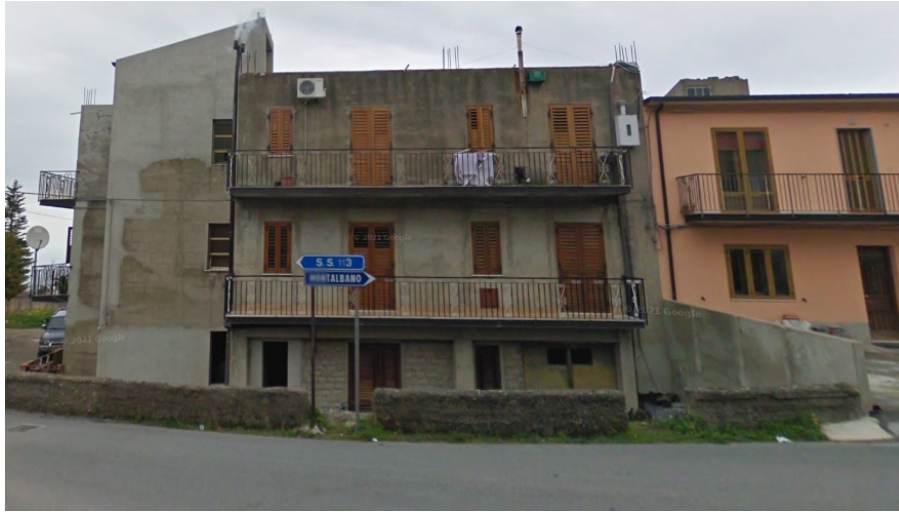
SP.112 Km 1+510 INTERVENTO 1
