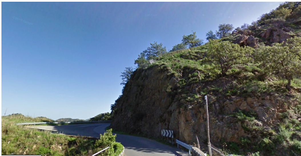
SP.115 INTERVENTO 6 Km 4+100
