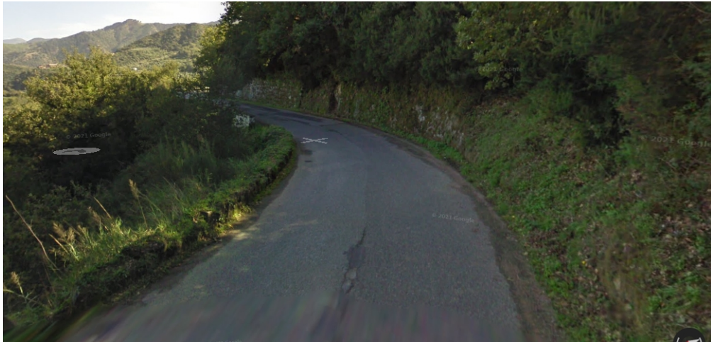
SP.115 INTERVENTO 4 al Km 3+190
