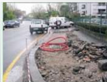
Situazione non regolare, la chiusura del marciapiede costringe i pedoni ad andare sul ciglio della strada senza protezione
