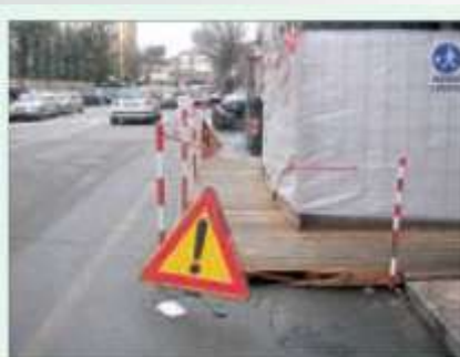
Situazione regolare, il passaggio pedonale è ben protetto
